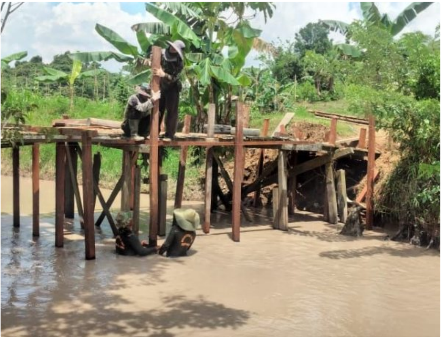
Karya Bakti Kodim 0906/Kkr sasar pembangunan jembatan penghubung kawasan pertanian desa Buana Jaya
